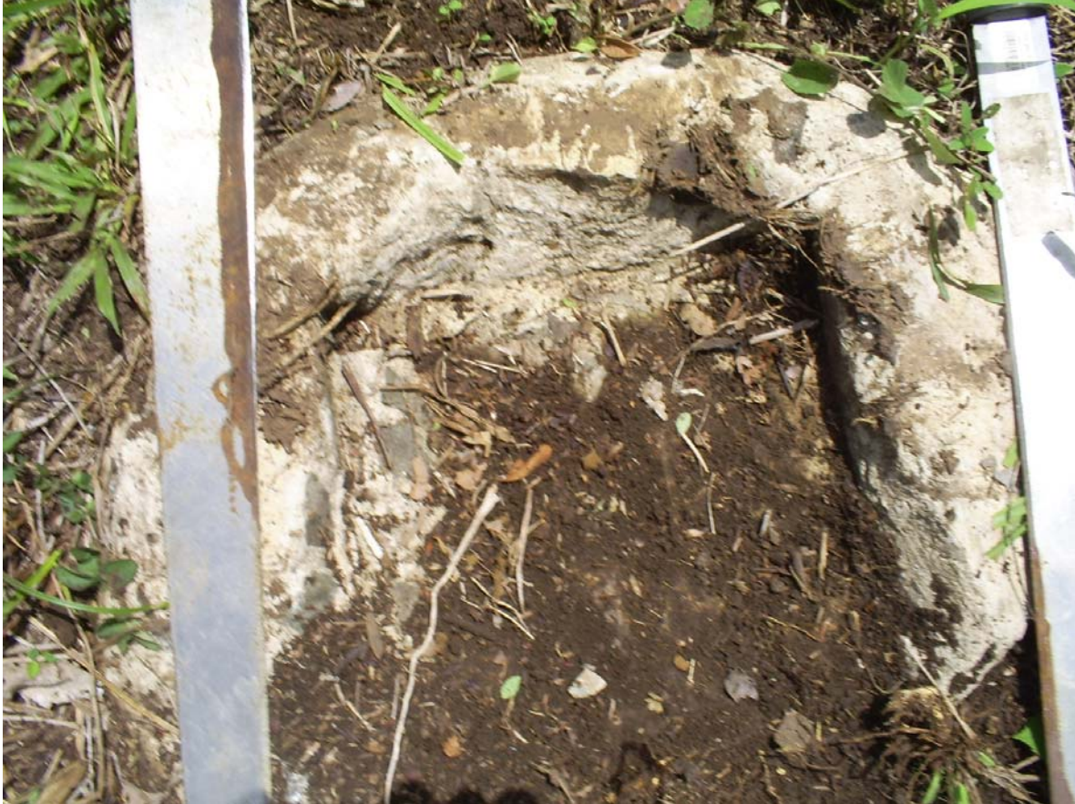
Vista de planta del BM Z-59 destruido.
